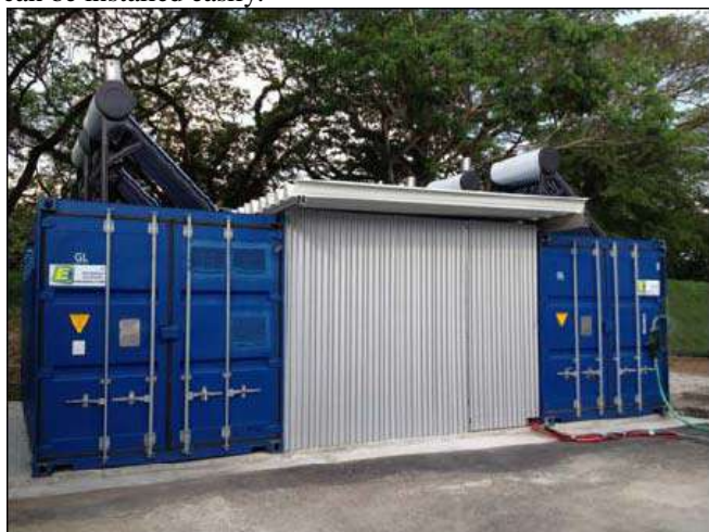
Fig.1. Mini Biogas Power Plant
