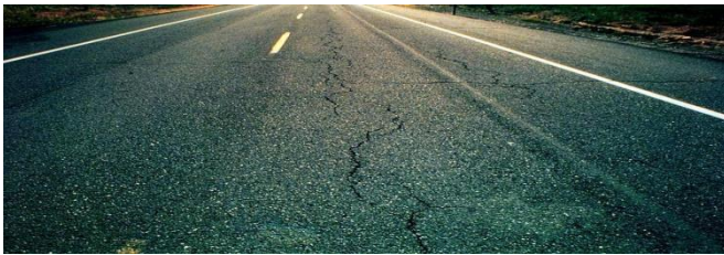
Fig. 4.5.2 Longitudinal Cracking
