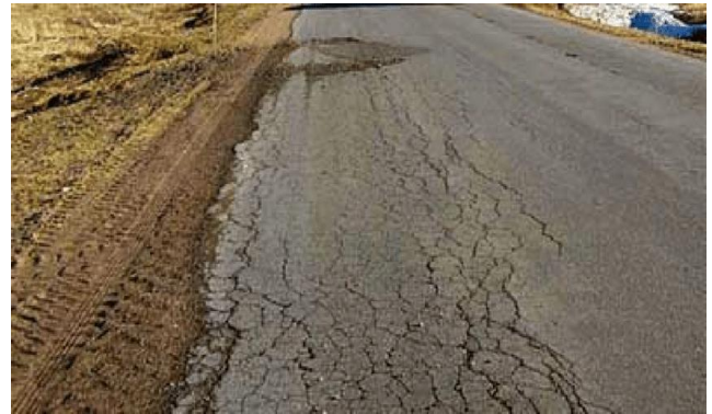
Fig. 4.5.3 Edge Cracking
